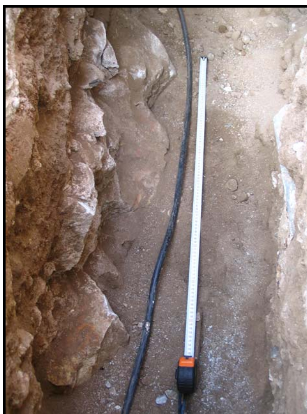
Foto núm. 10. Detall del mur UE 9.
