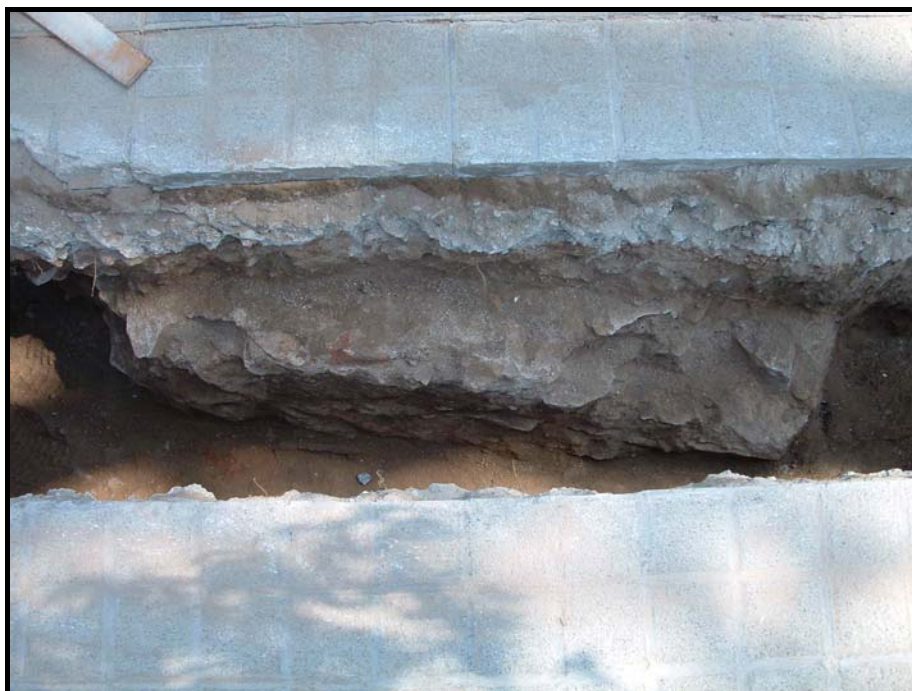
Foto núm. 11. detall del mur UE 12.
