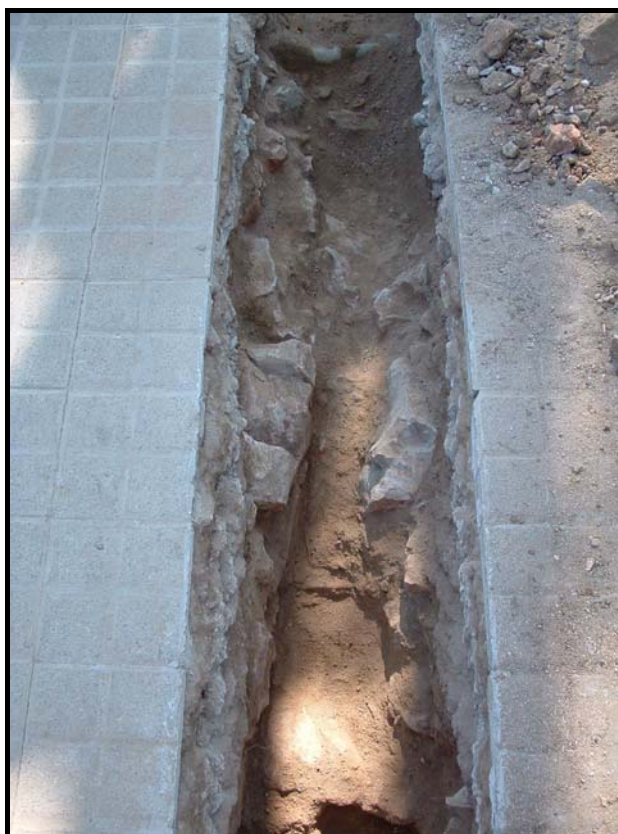
Foto núm. 12. detall del mur UE 10.
