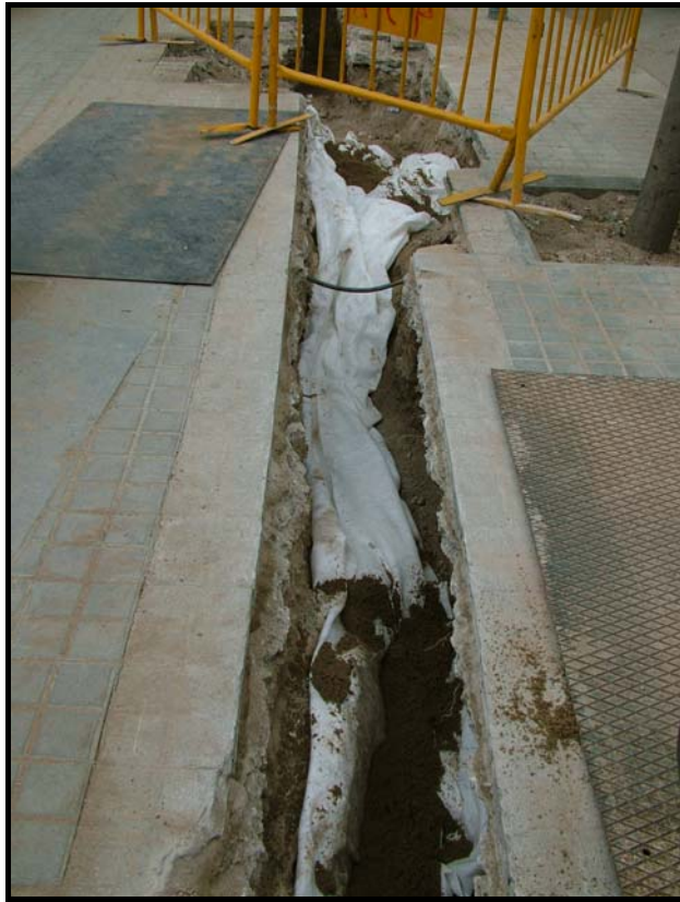
Foto núm. 17 restes arqueològiques protegides amb geotèxtil.
