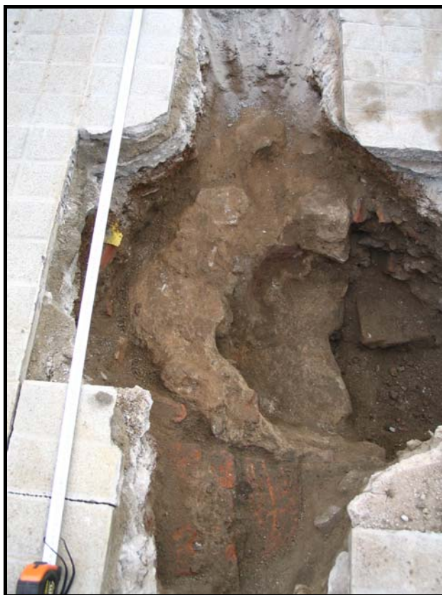
Foto núm. 13. Detall del mur UE 11.
