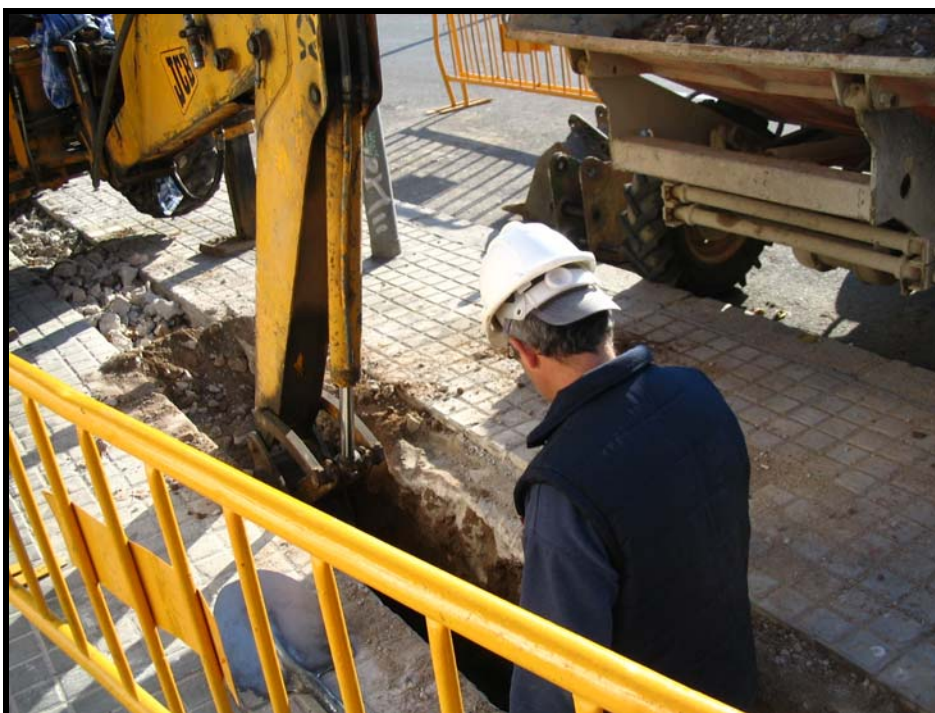
Foto núm. 2. Excavació de la rasa.
