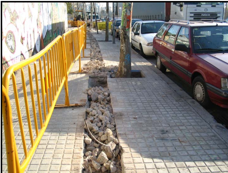
Foto núm. 1. Inici dels treballs. Demolició del paviment.
